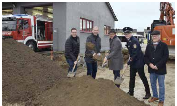
Eröffneten die Baustelle (von links): Architekt Robert Maier, Erster Bürgermeister Stephan Antwerpen, Feuerwehrreferent Dr. Stefan Schneiderbauer, Kommandant Alois Wieser jun. und stellvertretender Landrat Hubert Gschwendtner.
