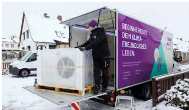
Einbau einer Wärmepumpe von 1KOMMA5°
