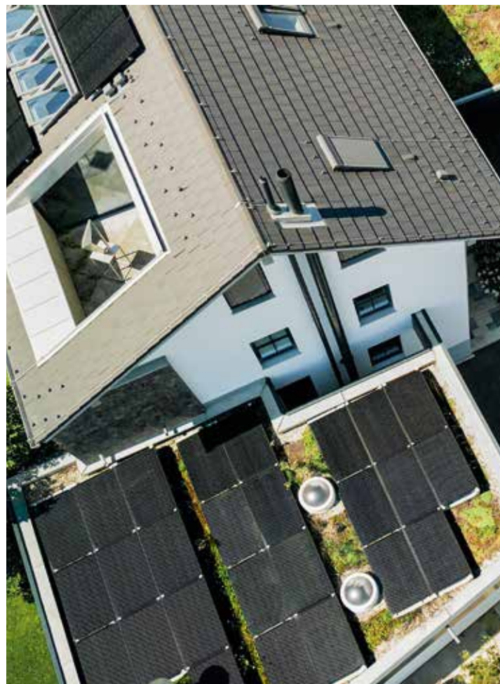
Solaranlage auf Dach bei 1KOMMA5° Kunden
